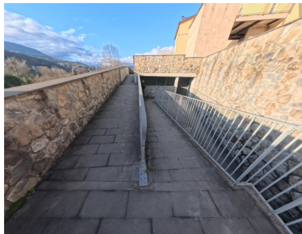
29 Rampa che collega ascensore – Teatro
