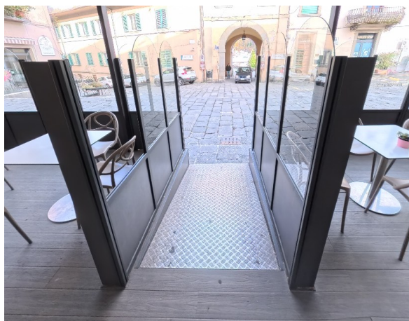
38 Rampa per accesso Bar
