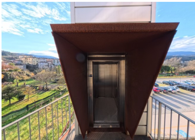
28 Ascensore che collega parcheggio Teatro – rampa
